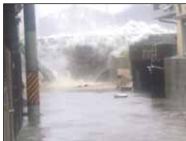
平成 16年台風 18号 高潮による越水
